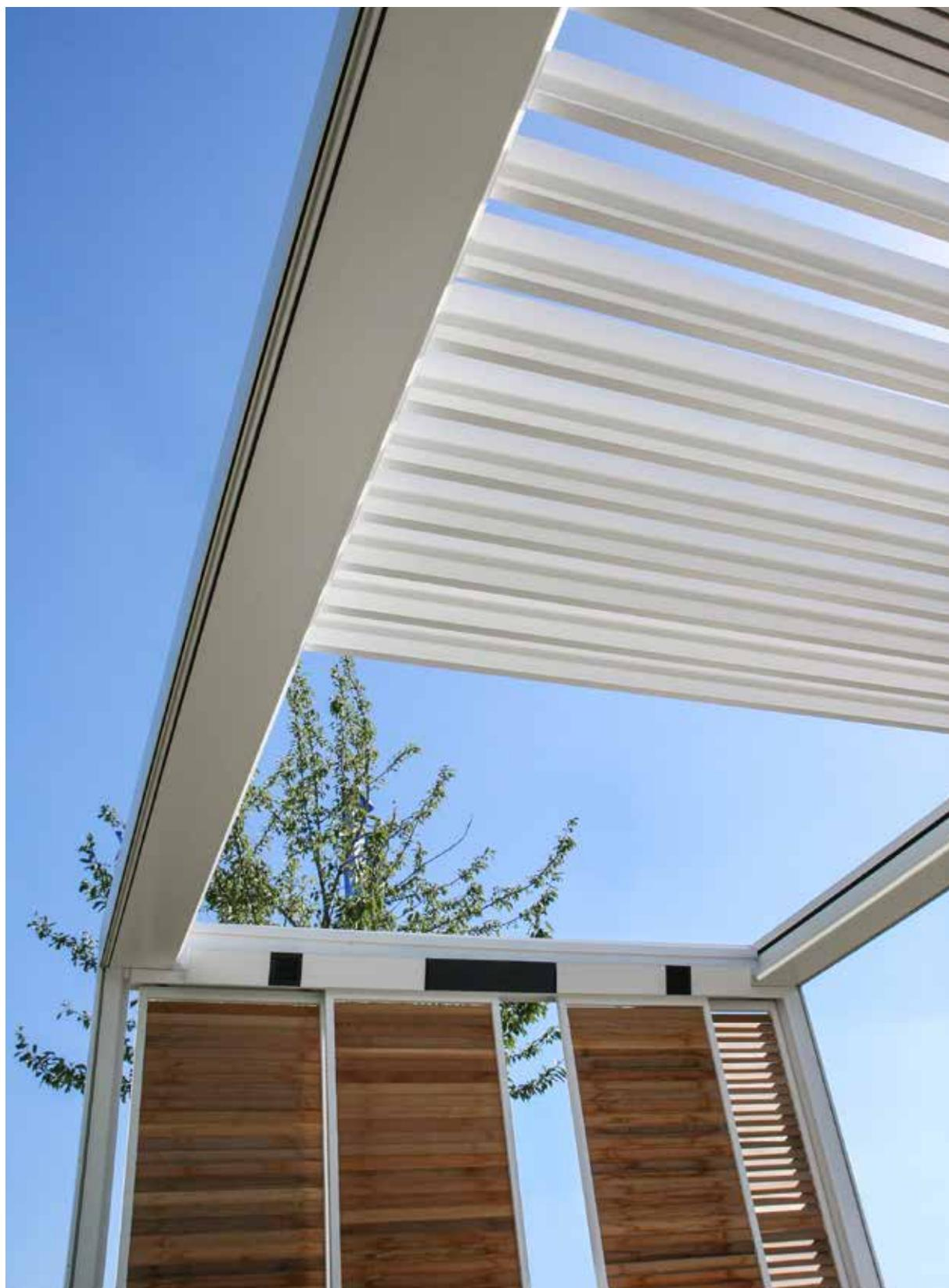
Skye est une toute nouvelle toiture de terrasse innovante et unique comportant des lames orientables et rétractables en aluminium. Ce nouveau type de toiture de terrasse est un concept révolutionnaire conçu par Renson.
